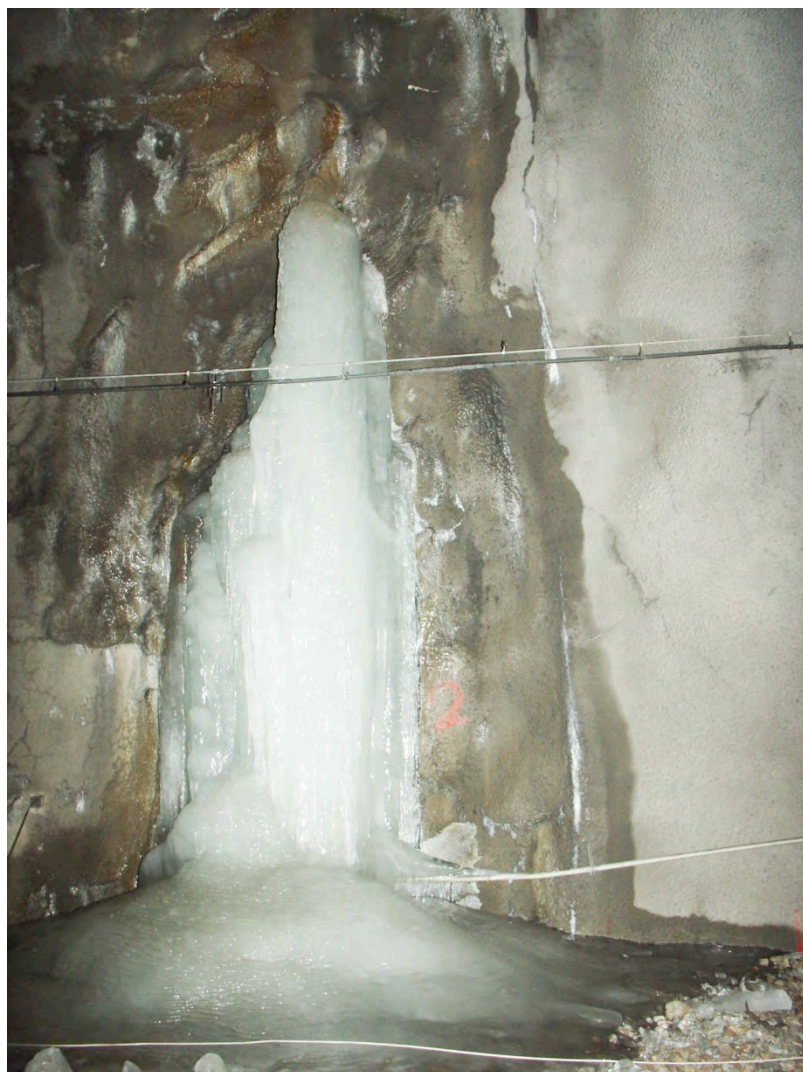
Figur 8. Läckage vid sidan av drän, isen belastar handledare som brutits sönder. (Foto: A. André).
