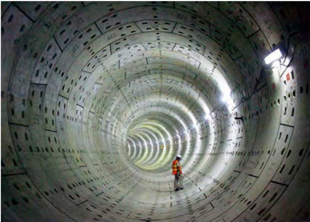
Figur 14 Den övre bilden visar en platsgjuten lining i en sprängd tunnel och den undre en lining uppbyggd av prefabricerade element monterade i en TBM – borrarad tunnel.
