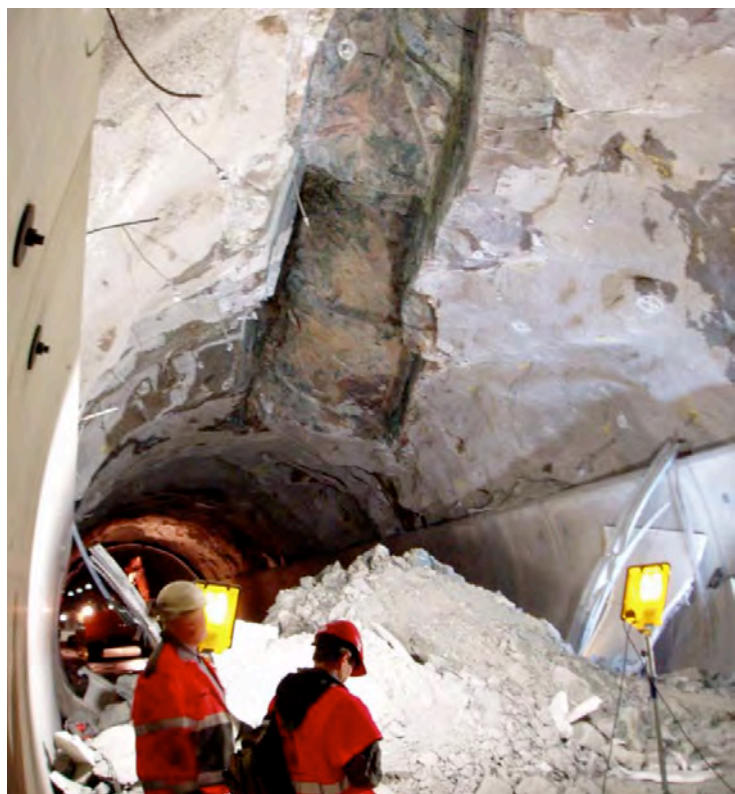
Figur 13. Ras vid Hanekleivtunneln, Norge
