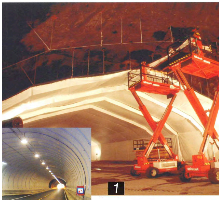
Figur 11. Montering av membraninklädnad, typ tunnelduk.
