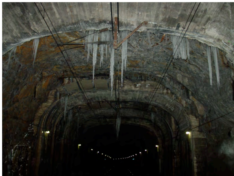
Figur 7. Istappar som gör intrång på det fria rummet och som måste tas ner innan ett tåg kan passera. (Foto A. Andrén)
